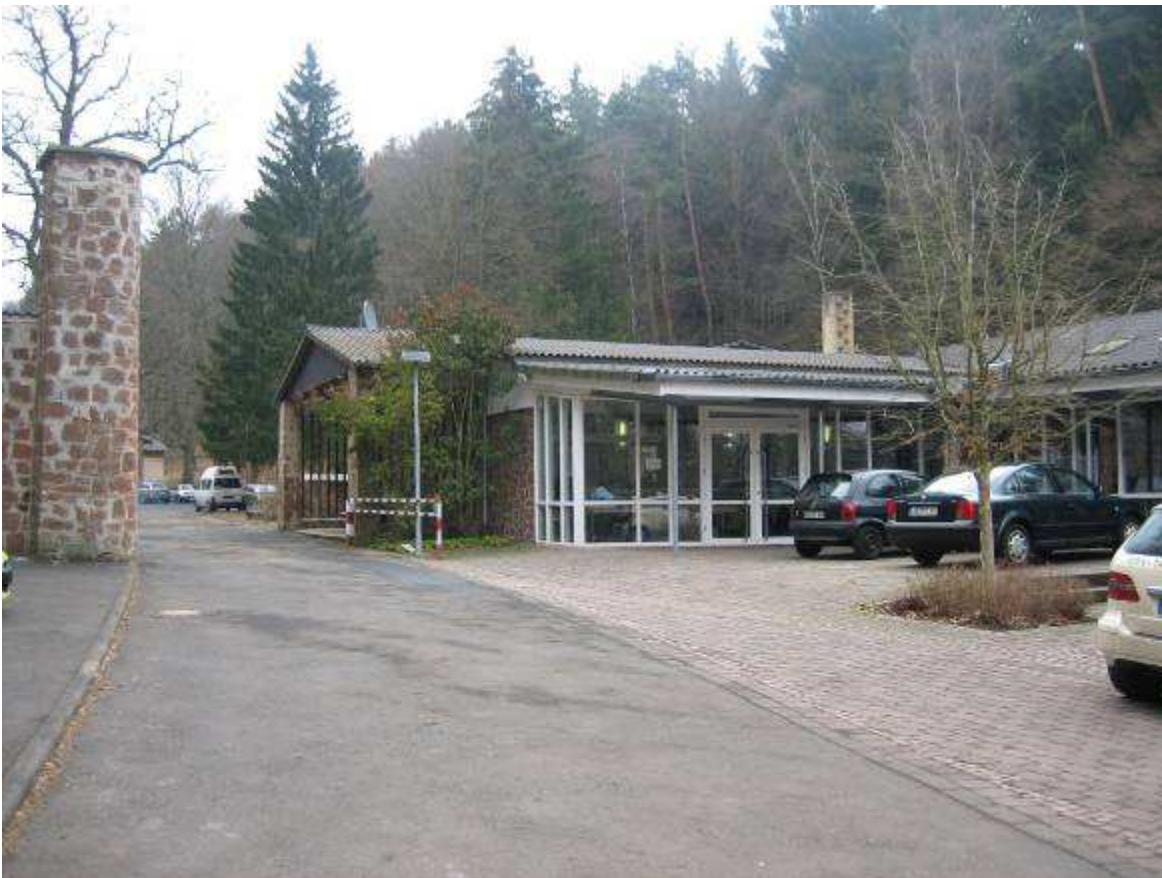
Rechts, am Eingang des Geländes, befindet sich der Tagungsteil mit der Küche und dem Essraum.
